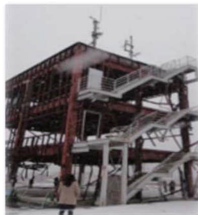
近隣の町の防災庁舎(現在では取壊しが決定)
